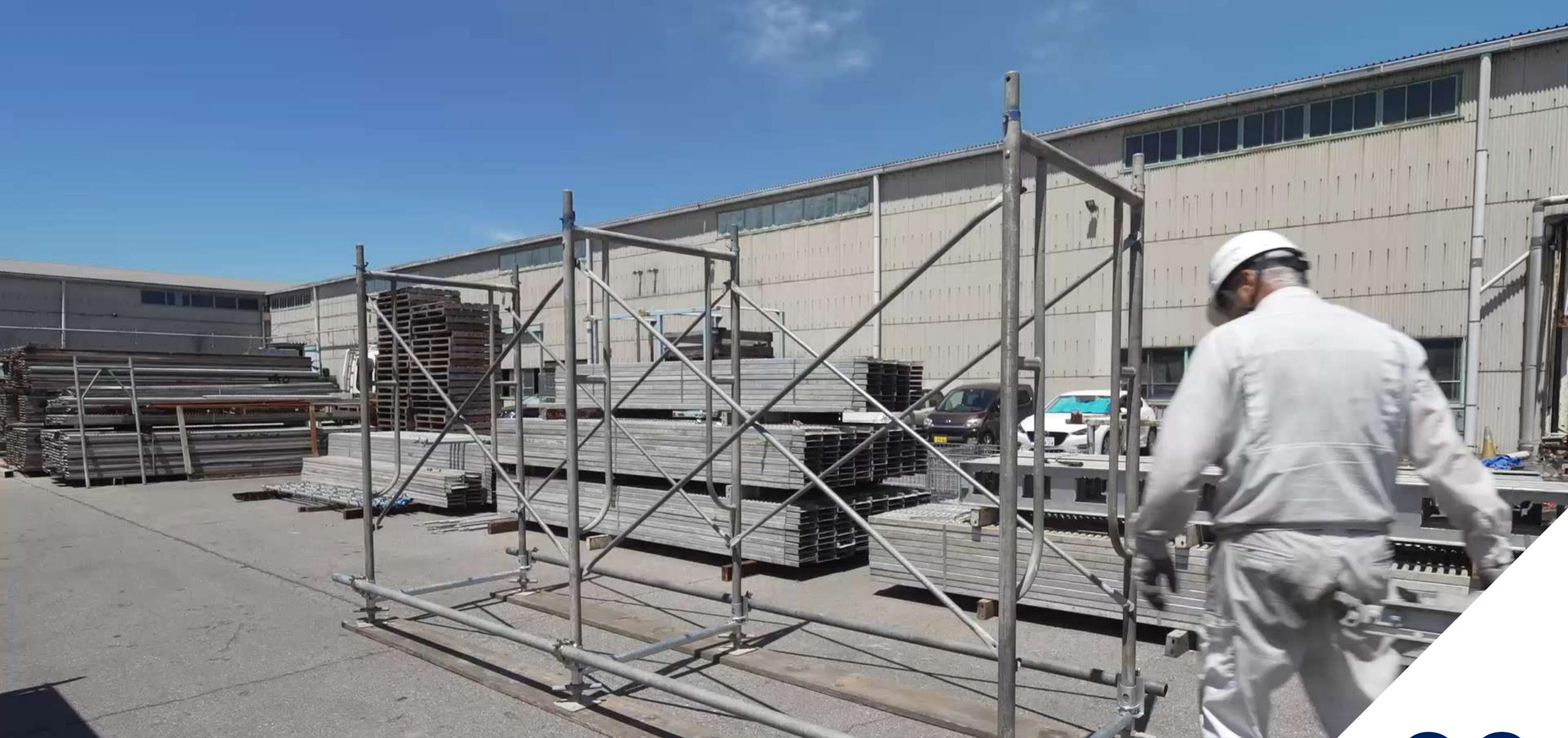
布板・階段を設置し1段目の建枠の組立が完了
