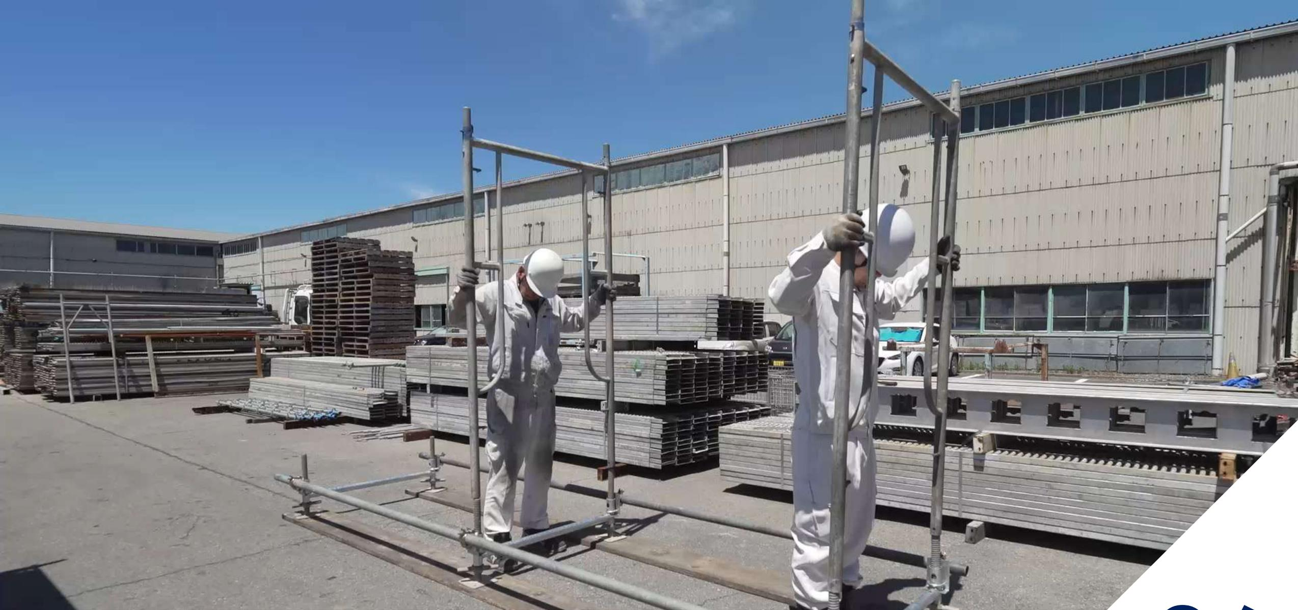
建枠を根がらみ金具に差し込み設置。
